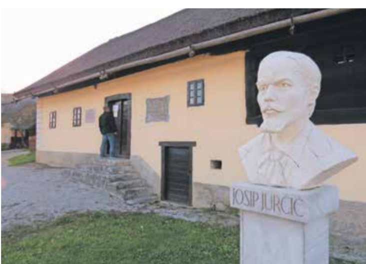
Jurčičevo rojstno hišo je postavil pisatelj ded in doslej ni bila predelana. FOTO BOJAN RAJŠEK
